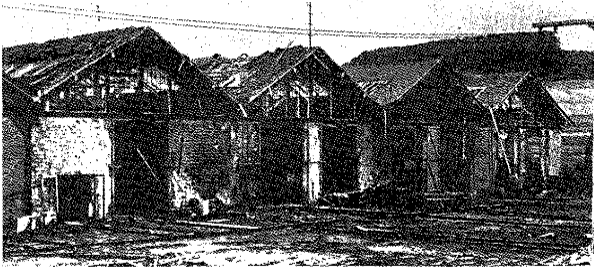
Montage des wagons.
