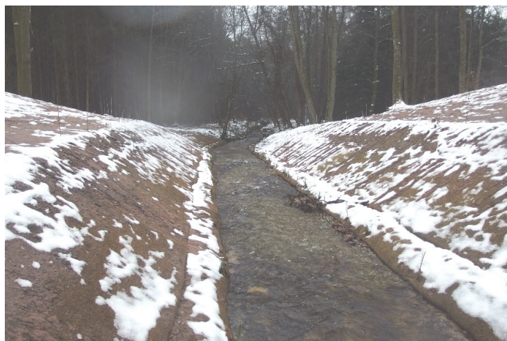
Digue de l'étang après les travaux de 2014
