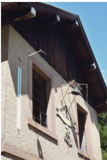
Méridienne sur la façade de l'ancienne forge De Dietrich à Jaegerthal
