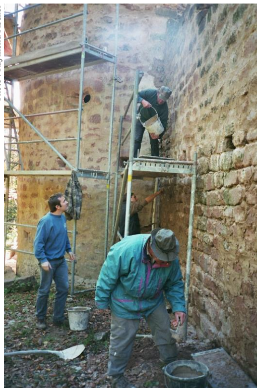
Château de Schoeneck en octobre 2007. Quelques membres de l'association effectuant un travail de jointage sur le rempart de la basse-cour Est.
