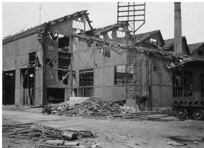
La Schmelz – Bat. 312 : rivetage et annexe (coté sud)
