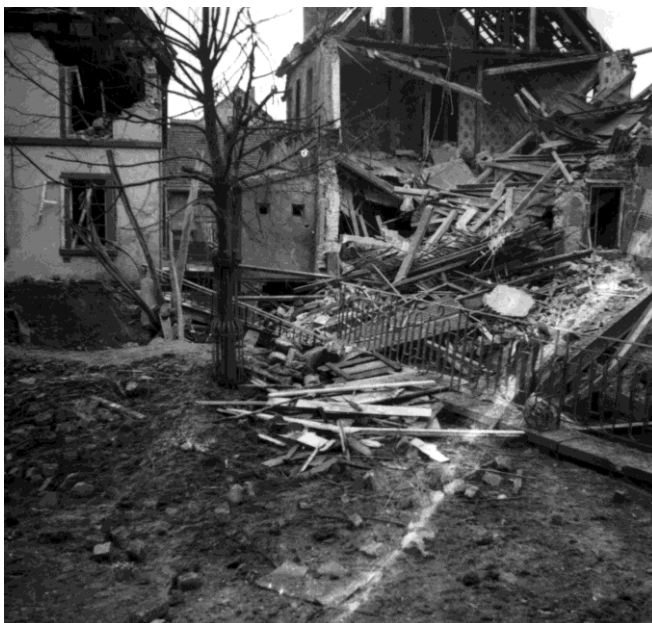
Destruction du restaurant « Au Raisin » et du Pont au croisement (Act. Rue du Gal Leclerc)
