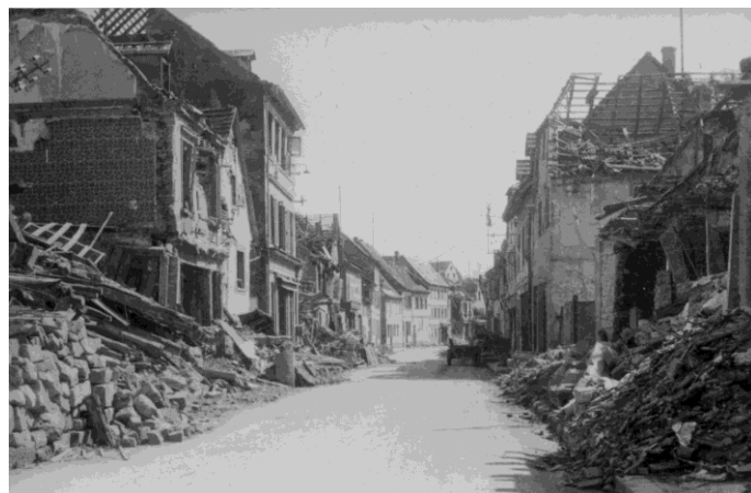
Rue Principale à Niederbronn
